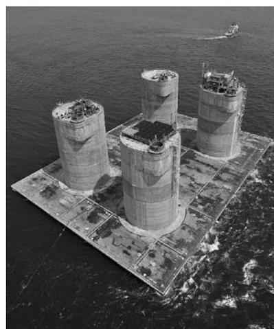
**Рисунок 2. Бетонный ледозащитный пояс платформы «Беркут»**
