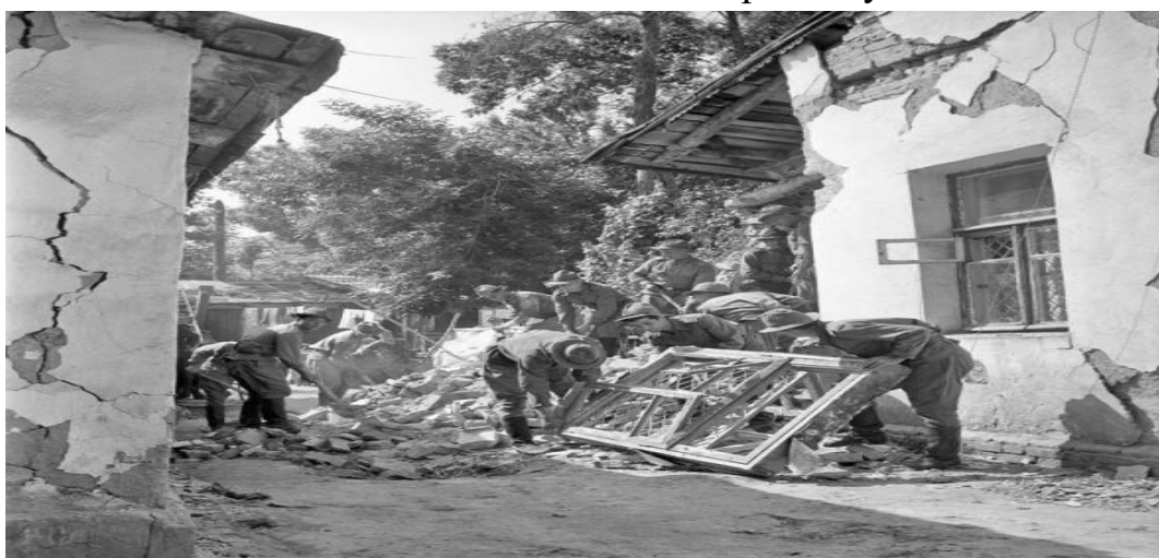
Рисунок 1. Последствия землетрясения . Ташкент . 26.04.1966 г.
