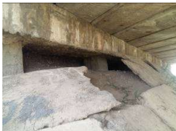
3–расм. Кўприк четки таянчларини мустаҳкамлашда юзага келадиган нуқсонлар
