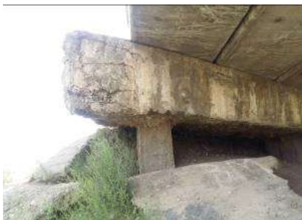
2–расм. Кўприк четки таянларининг характерли емирилишлари
