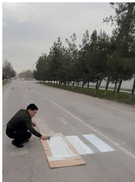
Рисунок 2. Нанесение лакокрасочного покрытия
