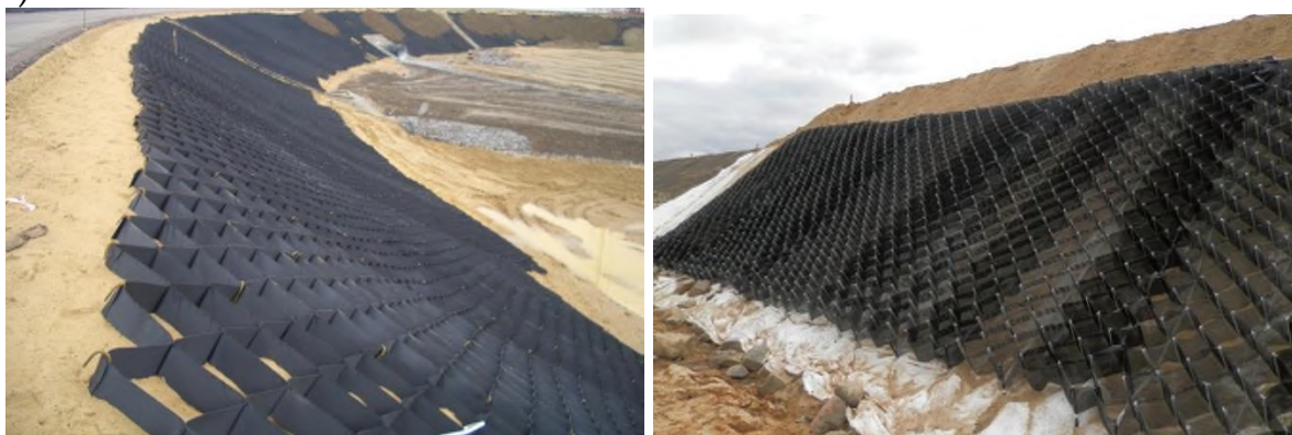
Рисунок 1. Укрепление откосов с использованием объемных георешеток: а) – конструкция укрепления откоса выемки; б) – производство работ по укреплению откоса.
