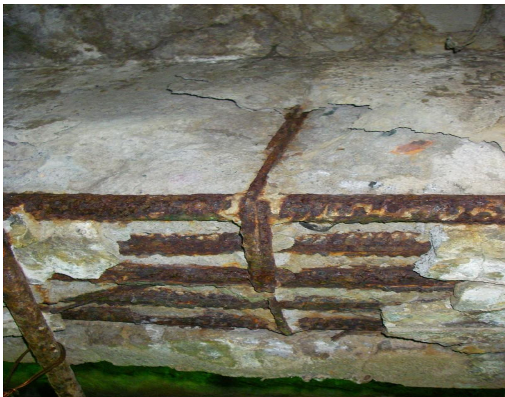
2-rasm. Ko'prik konstruksiyasining shikastlangan qismi
