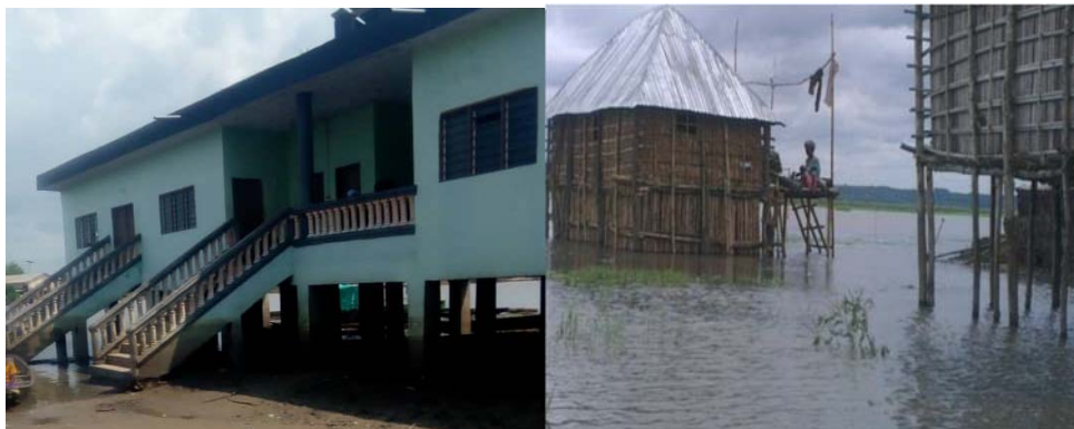
Planche 6: Construction sur pilotis en matériaux modernes et précaires à Hêtin-Sôta (arrondissement de Kessounou).
