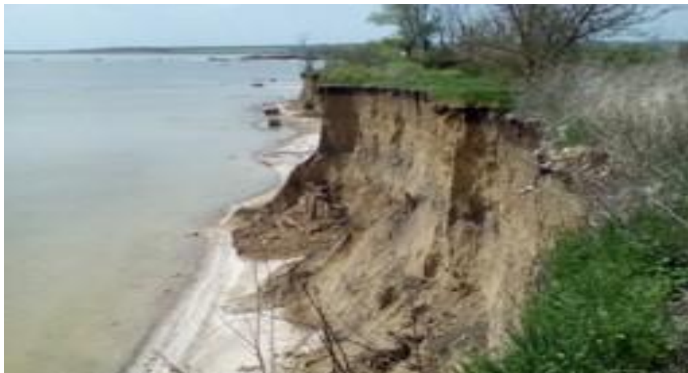
Рис 2. Абразионно-обвальные процессы в районе домовладения № 140 по ул. Октябрьская в с. Весело-Вознесенка. Створ №3 (фото; 03.05.2018)
